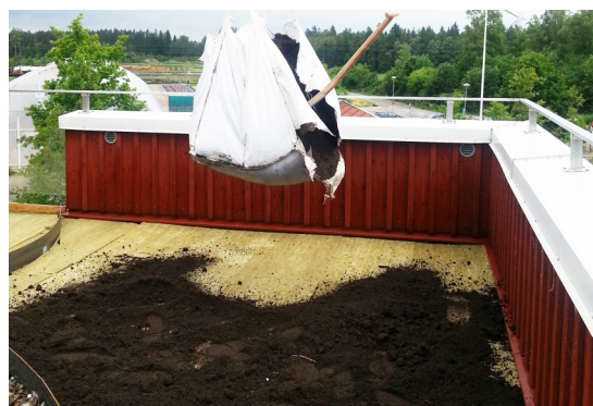
Grodan och bjälklagsjord
