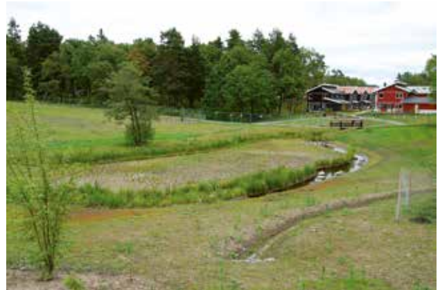
Här leds dagvattnet ned till en översilningsyta som i sin tur fördröjer och renar dagvattnet innan det förs vidare. Dagvattenprojekt Tollare park, Nacka kommun.
