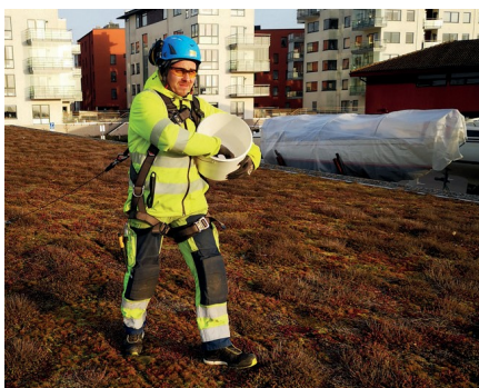
Gjødsling av sedumtak.
