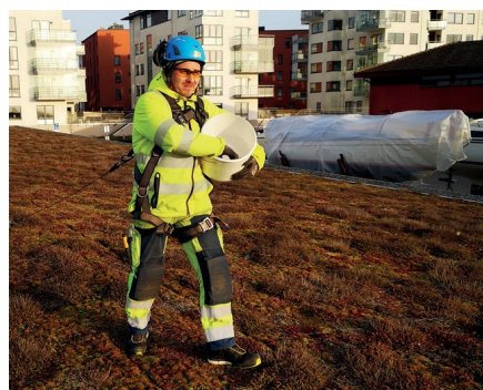
Gjødsling av sedumtak.
